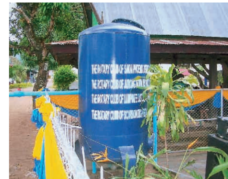
貯水タンクタワーおよび浄水器
