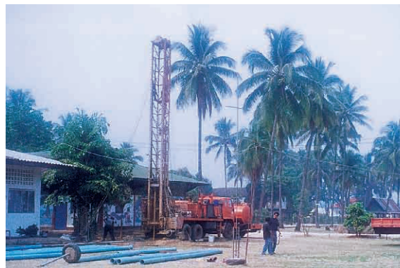
地質工学面のデータ調査の結果 地下100メートルで水を発見
